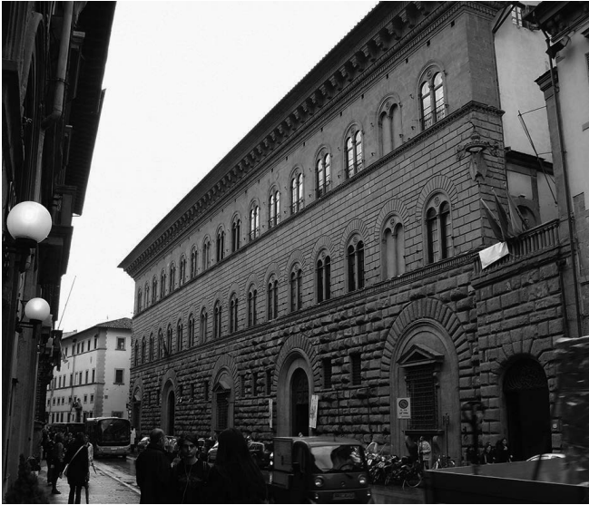
Palacio Medici en vía Cavour, Florencia.
